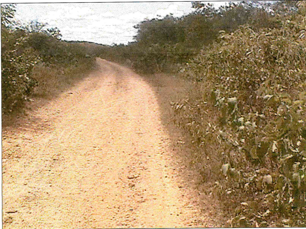
FOTO 05 - Estrada junto à ombreira direita (solo residual)
