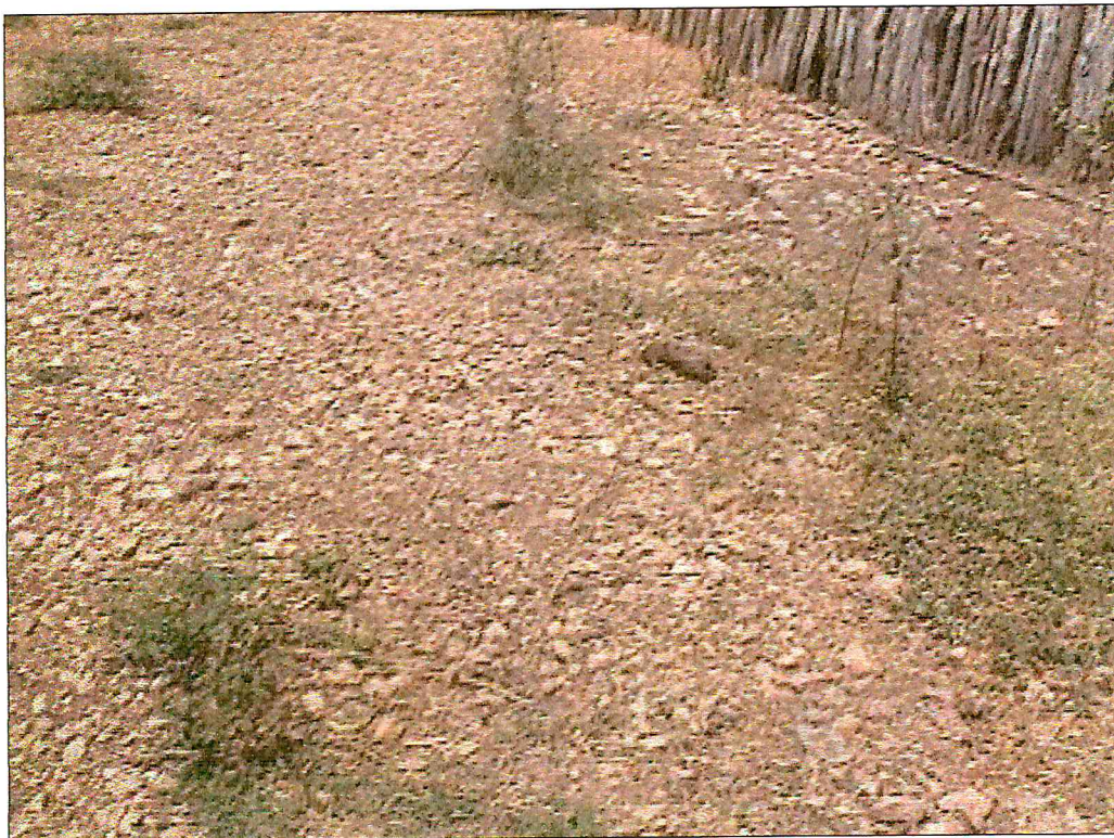
FOTO 04 - Solo residual pedregulhoso na ombreira direita
