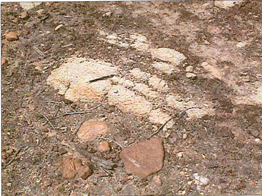
FOTO 06 - Rocha aflorante na ombreira direita
